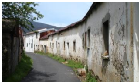
Fotografia 28: Degradação do edificado na Panasqueira
