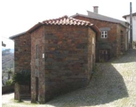
Fotografia 3: Recuperação do edificado
