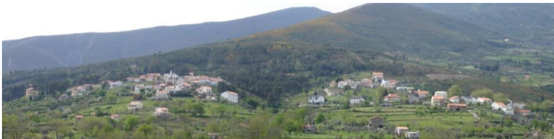
Fotografia 35: Vista do Bairro da Terra da Senhora (esquerda) e Lombinha (à direita), em Unhais da Serra
