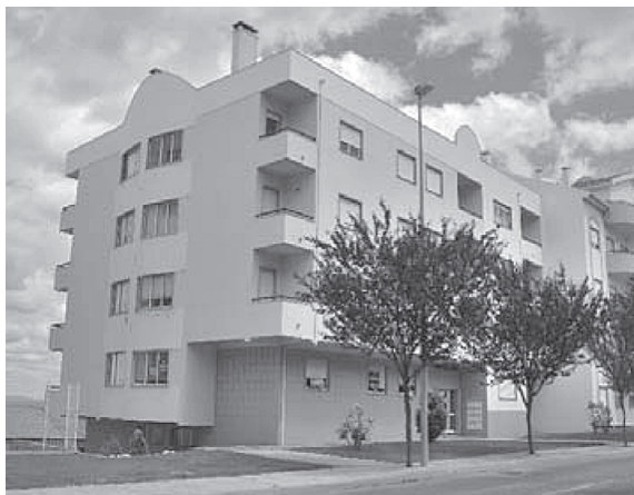
Fachada do prédio
