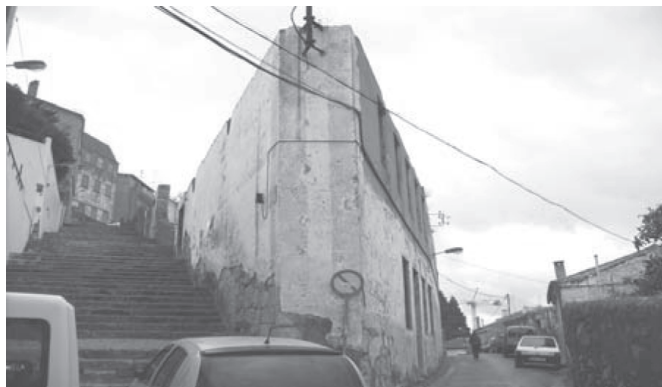
Fachada do edifício
