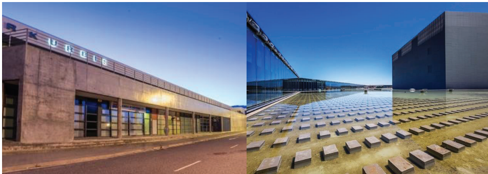
Figura 84. Parkurbis e Data Center da Covilhã
