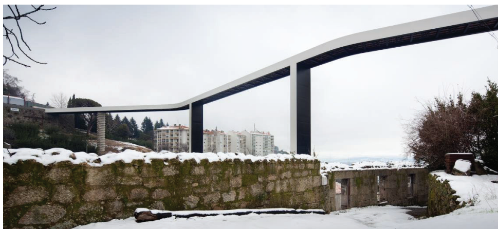
Figura 5. Ponte pedonal da Ribeira da Carpinteira
