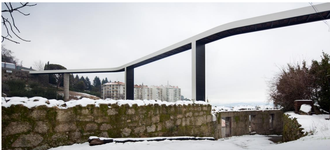
Figura 5. Ponte pedonal da Ribeira da Carpinteira
