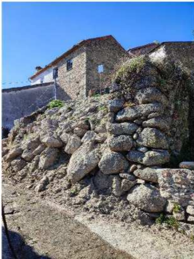
Foto n.º 1. Muro.
