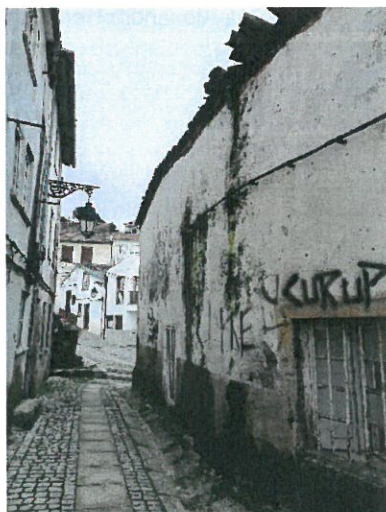
Foto 3. Fachada posterior do edifício localizado na Rua Alexandre Herculano n.º 24 e 26.
