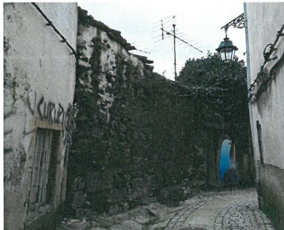
Foto 4. Parede pertencente ao edifício localizado na Rua do Cotovelo n.º 28.
