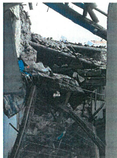
Fotos 9. Pormenor do interior do edifício localizado na Rua Alexandre Herculano n.º 24 e 26.
