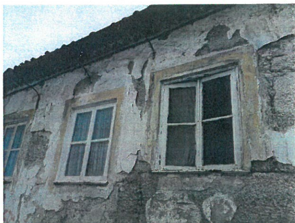
Foto 8. Pormenor dos vãos de janela.
