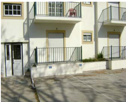
Fachada do edifício onde se integra a fracção
