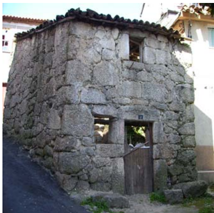
Fachada do edifício
