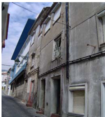
Fachada do edifício
